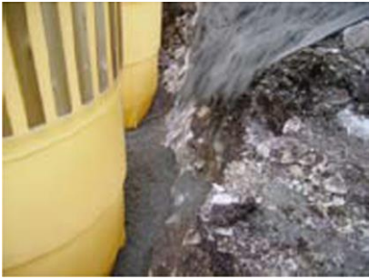
Giessen von Ballastbeton für der statische Auftrieb entgegenwirken
