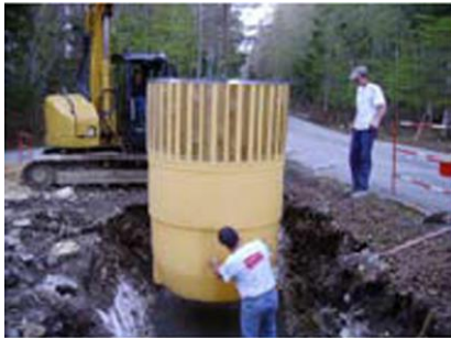
Einsetzen der Behälter von 140 Kg
