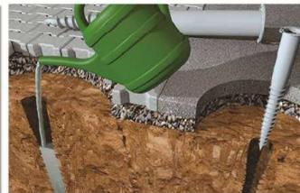
6. Bei zu grossen Einschraubwiderstand helfen erneutes Vorbohren, Wässern des Bohrlochs oder das Vordrehen eines kleineren Fundaments.
