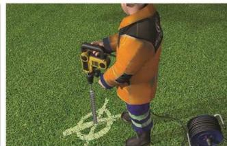
4. Vorbohren mittels Schlagbohrmaschine oder Bohrhammer (Durchmesser 40mm).
