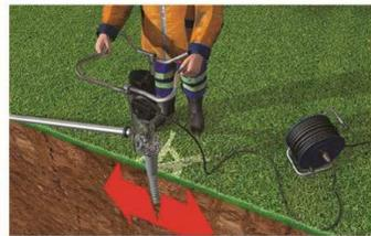
5. Beim Eindrehen der Fundamente wird das umliegende Erdreich verdichtet und dadurch die Stabilität erhöht.
