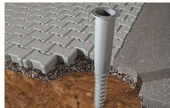
3. Oberflächenbefestigung um Einschraubpunkt ausreichend entfernen.
